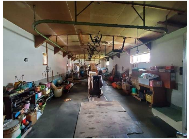
附属建物②（元工場）
