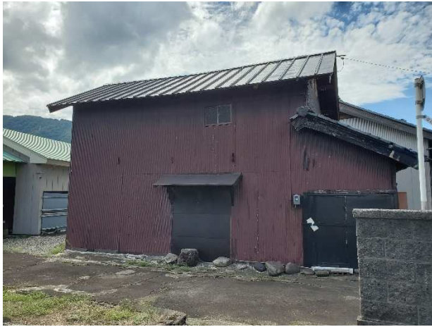
附属建物①（物置）
